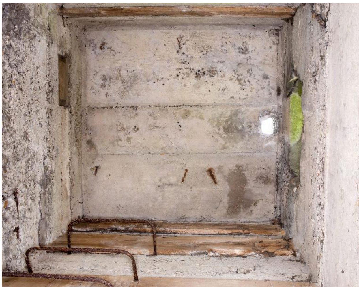
Vue intérieure zénithale
