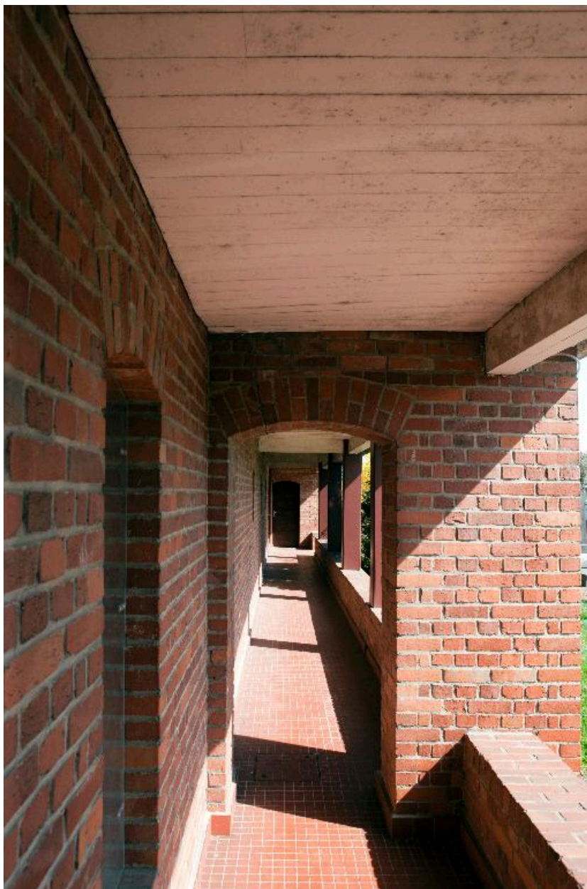
Détail du passage couvert bordant l'édifice.
