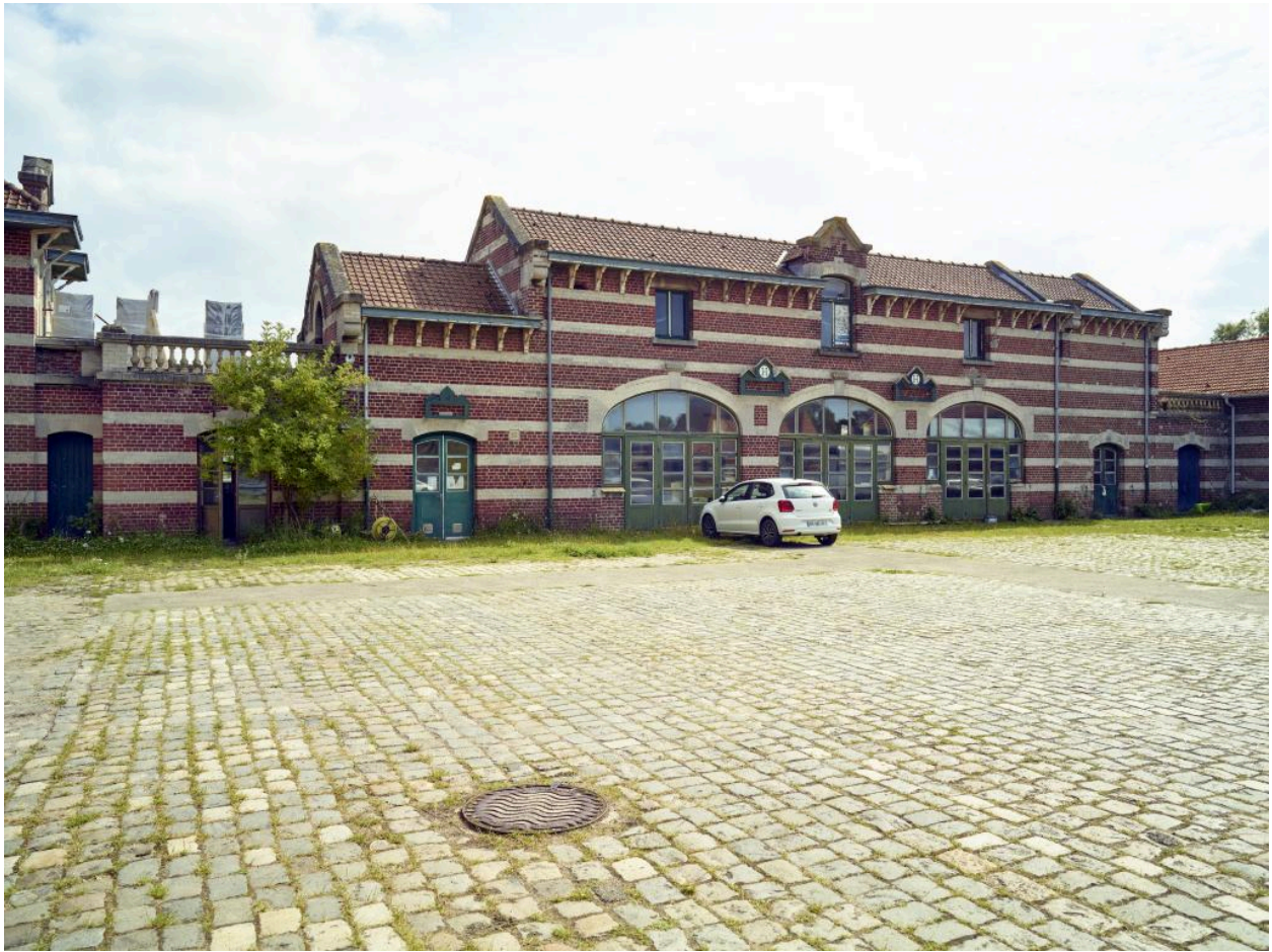
Façade sur cour de la remise à matériel agricole.
