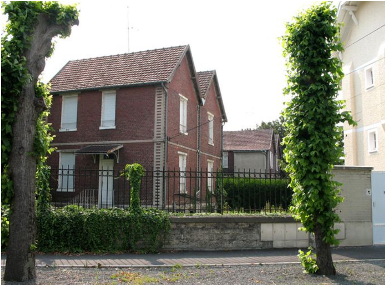
Logements de contremaîtres construits sur le site de la CIMA-Wallut.
