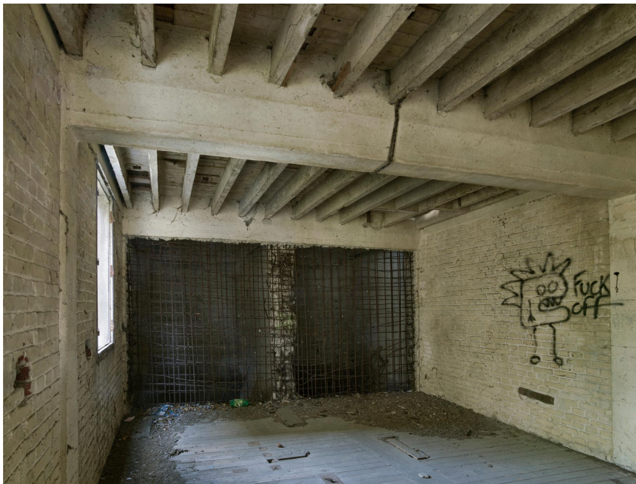
Intérieur du premier niveau de la minoterie, détail du réseau de ferrailage d'un des murs en béton armé.
