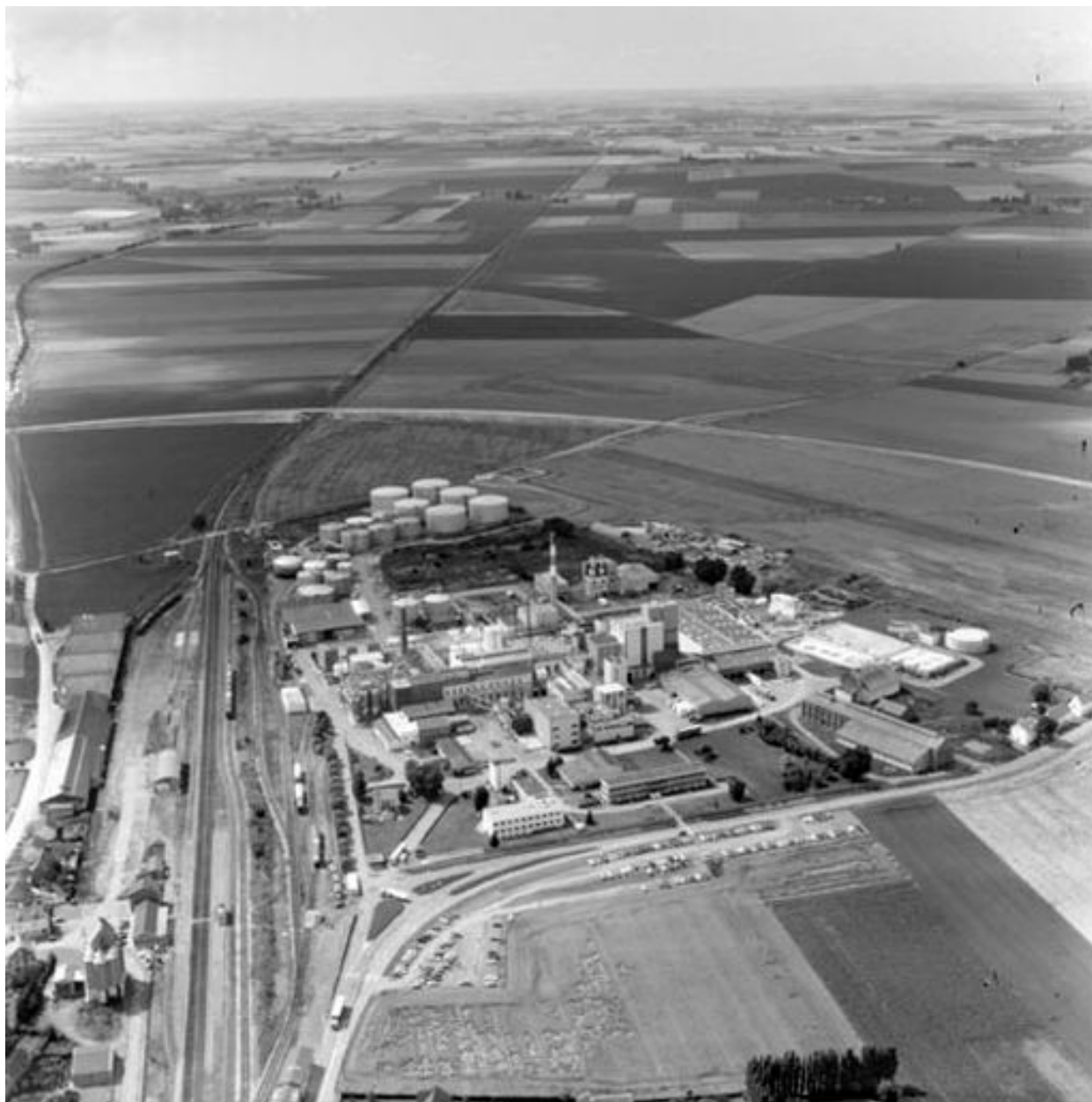
Vue aérienne, flanc est.
