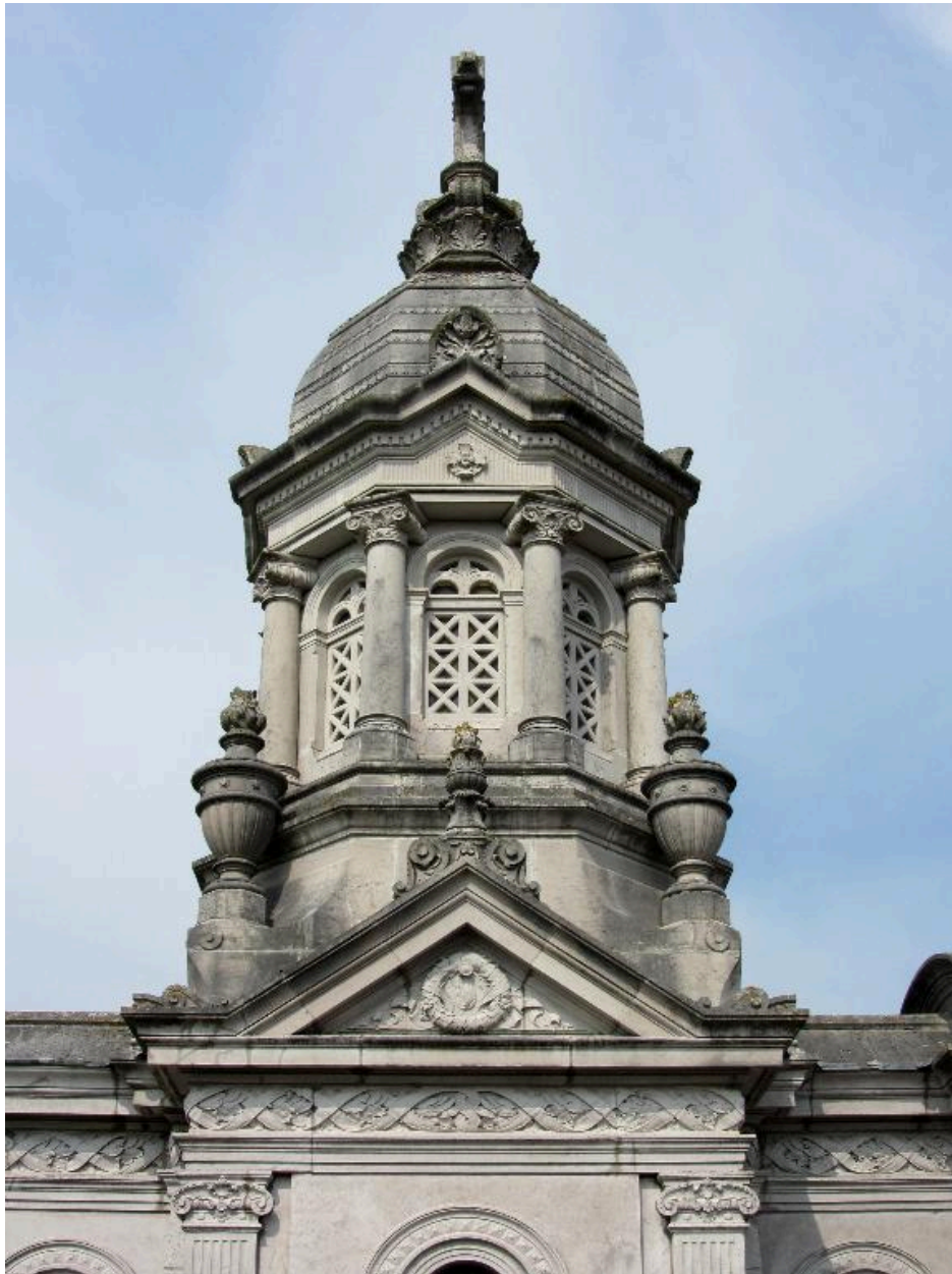
Détail du lanternon.
