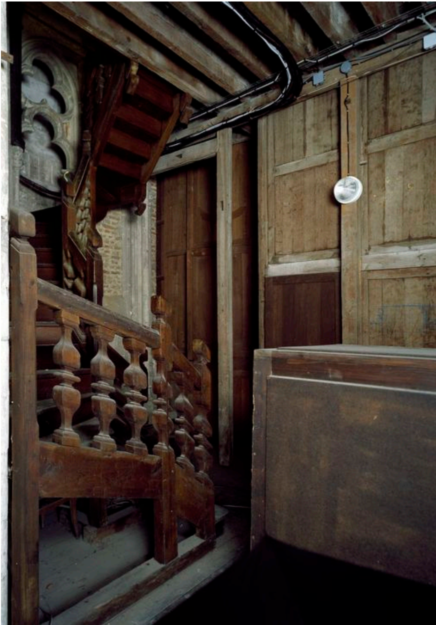
Vue latérale de l'escalier.
