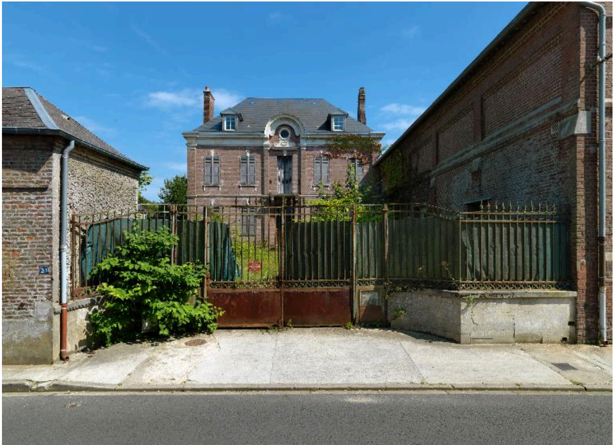
Vue depuis la rue Jean-Catelas de l'ancien logement patronal de M. Beauvisage.
