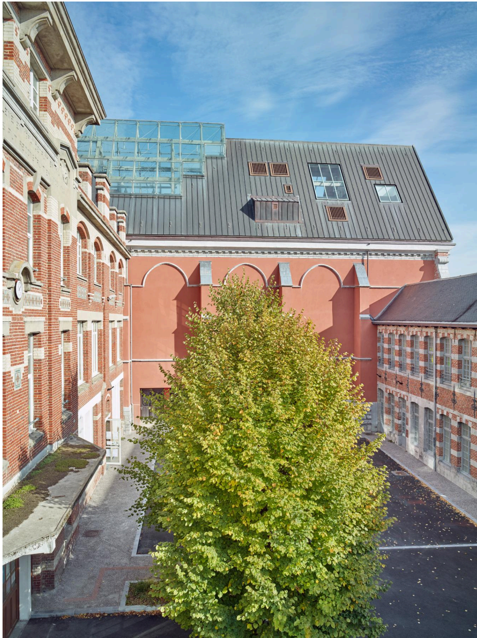
Vue depuis la cour au sud.
