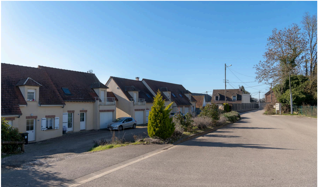
Lotissements du chemin de Bulles, vue prise depuis le nord-est.
