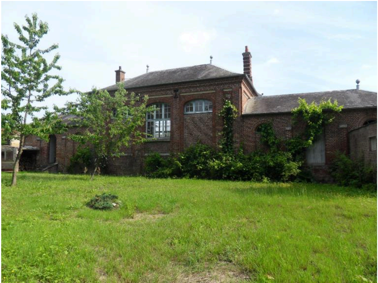
Vue de l'ancienne salle de classe, depuis le jardin, au sud.
