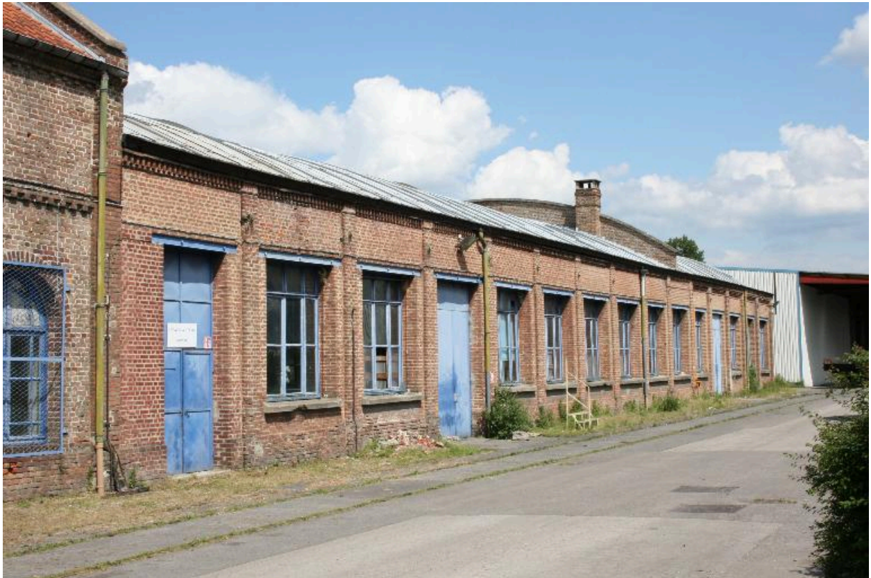
Façade sud des magasins.
