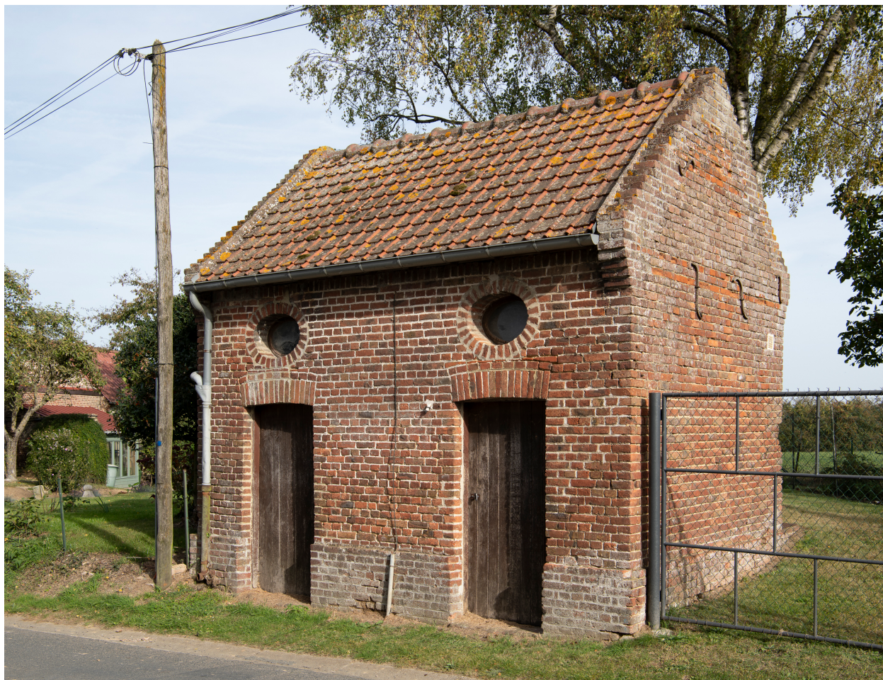
Ancien corps de garde, rue d'en-Haut, vue depuis le sud-ouest.
