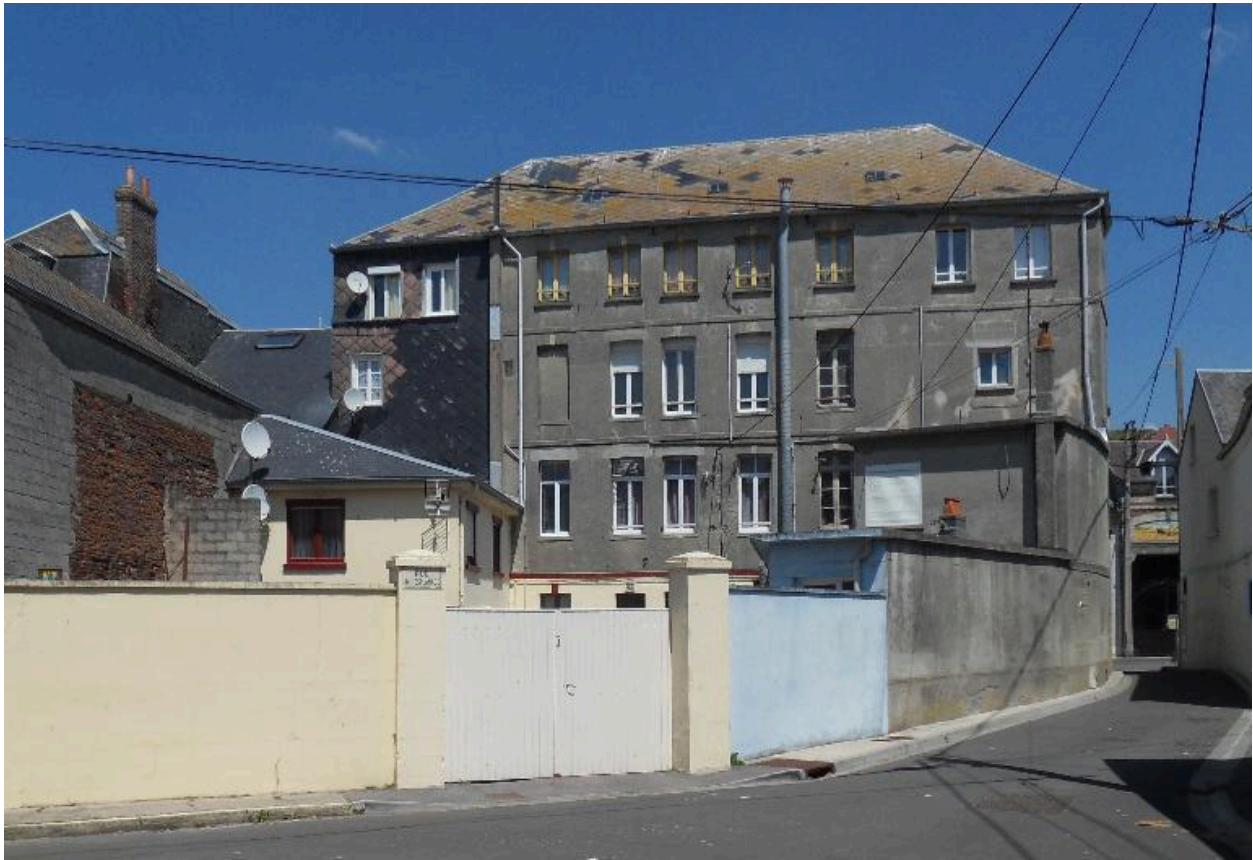
Vue de la façade postérieure.
