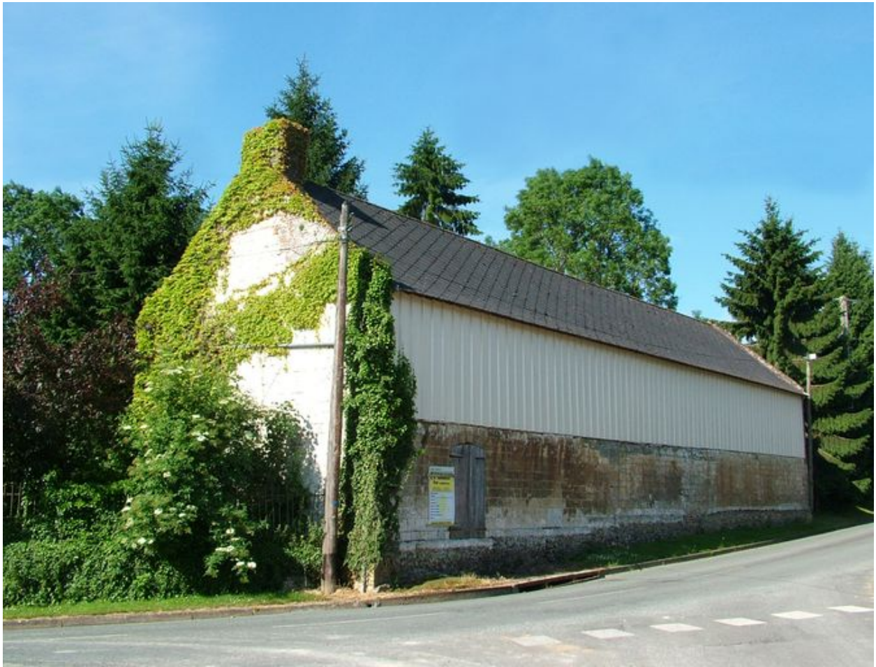
Ancienne grange, rue Principale, milieu du 19e siècle.
