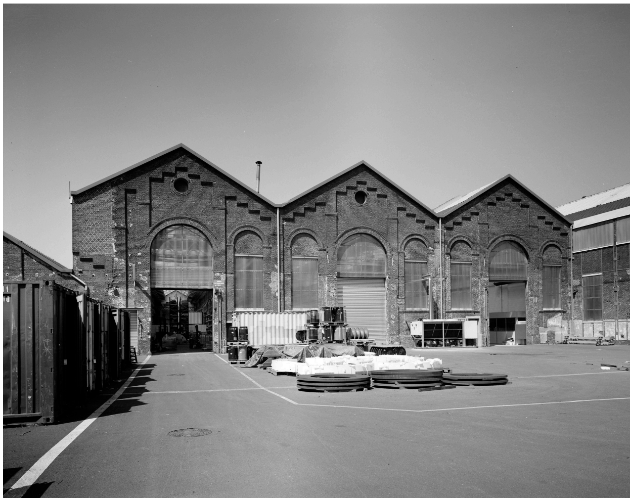
Vue générale des halles anciennes conservées : de droite à gauche, les halles 2, 3 et 4.
