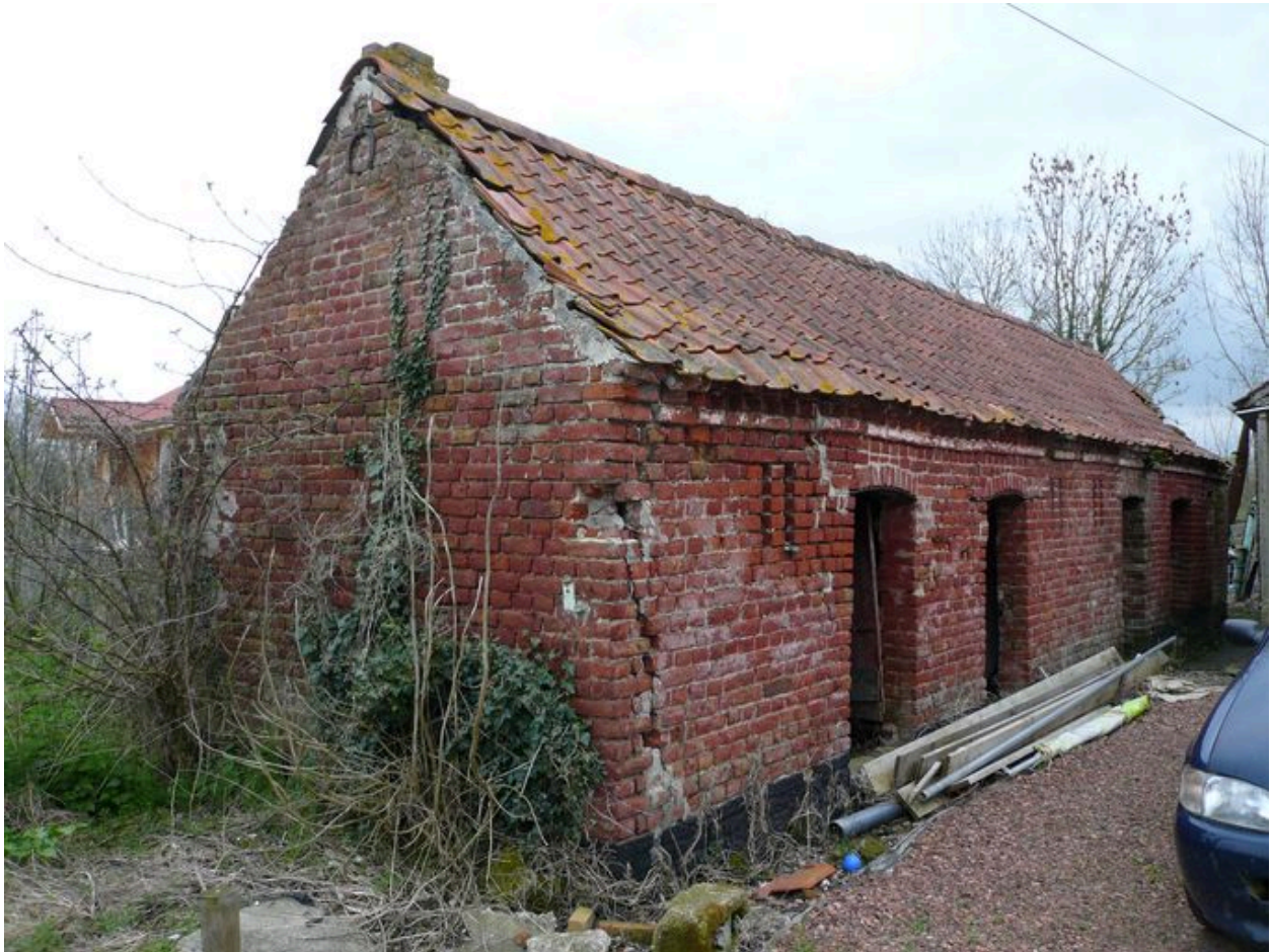
Vue des porcheries au nord-ouest.
