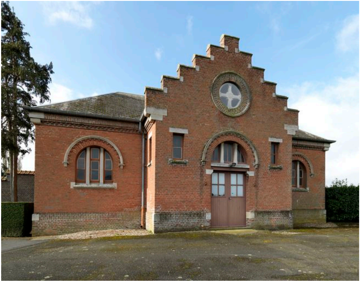
La chapelle. Vue depuis le nord.
