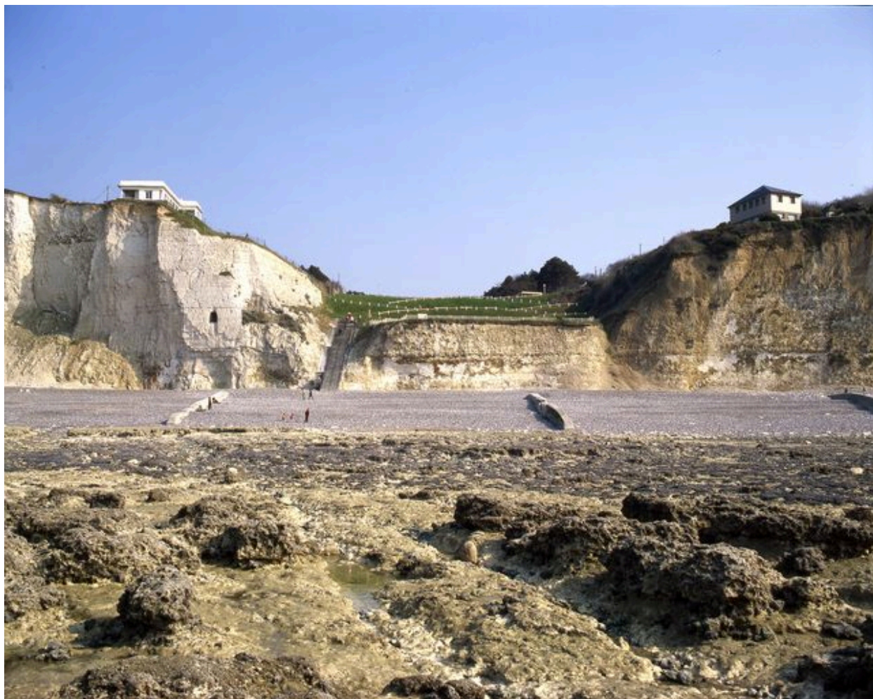
Le front de mer du lotissement, et la large entaille dans la falaise.
