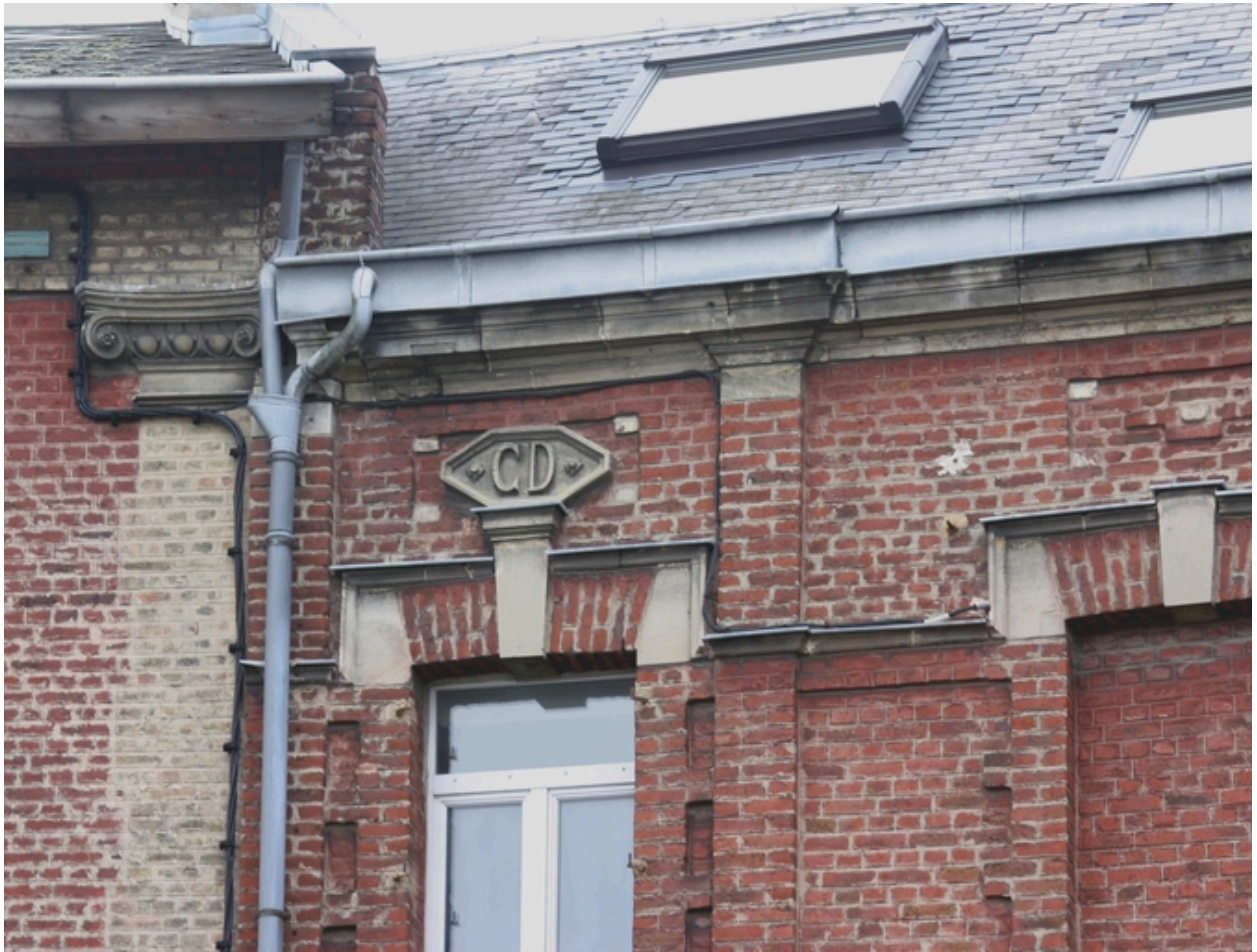
Façade antérieure des logements d'employés : détail.
