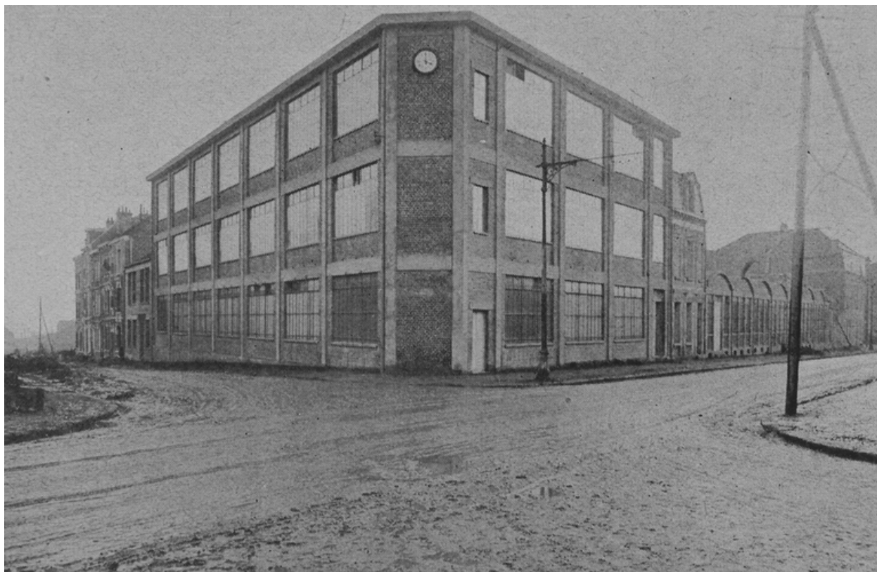
Façade de l'usine à l'angle de la rue de Bellevue et de la rue Pierre-Ramus, après les travaux de reconstruction, vers 1920-1922 (Le Monde Illustré).
