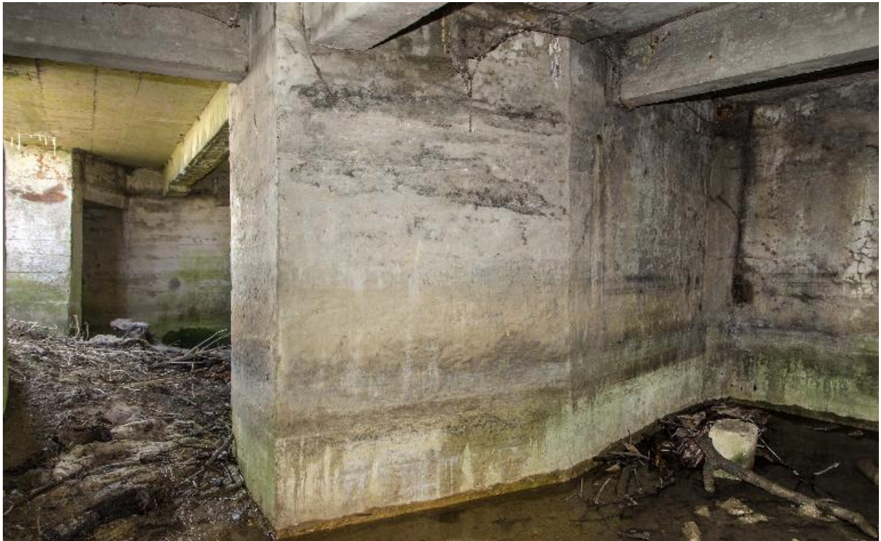
Passage de la soute à munition vers la chambre de tir
