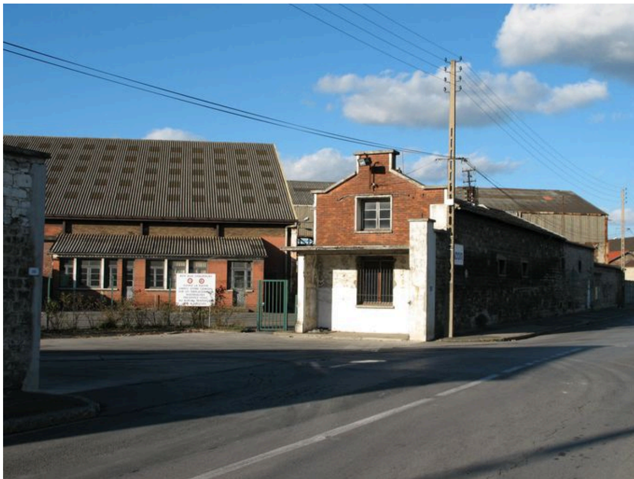
Entrée de l'usine.
