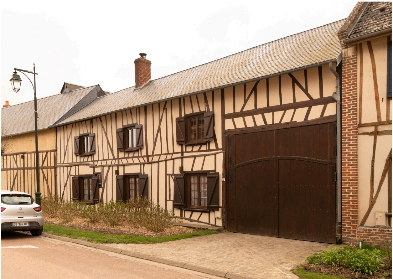
Logis sur rue avec entrée charretière, n°32 de la Neuve-Rue, vue prise depuis le nord.
