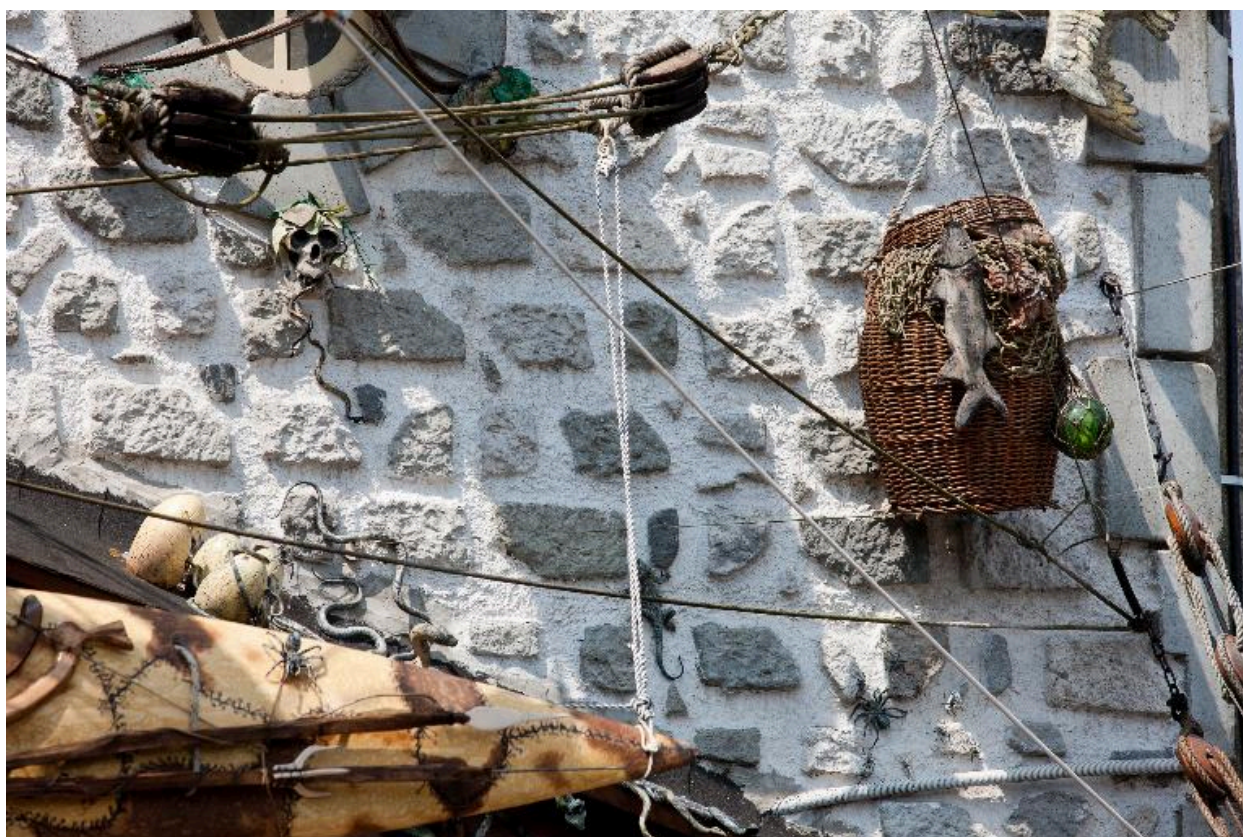
Vue partielle du pignon.
