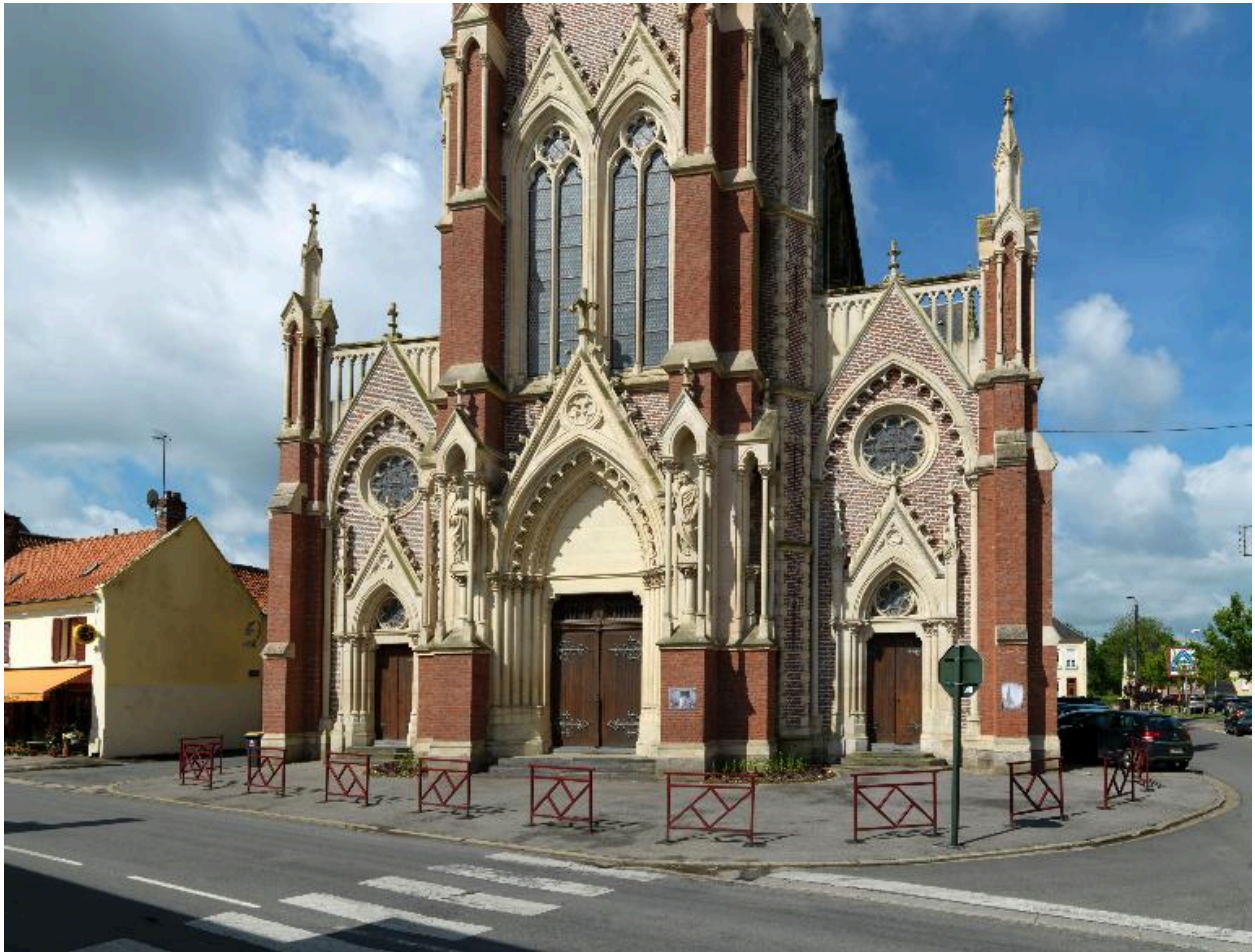
Détail du premier niveau de la façade orientale.
