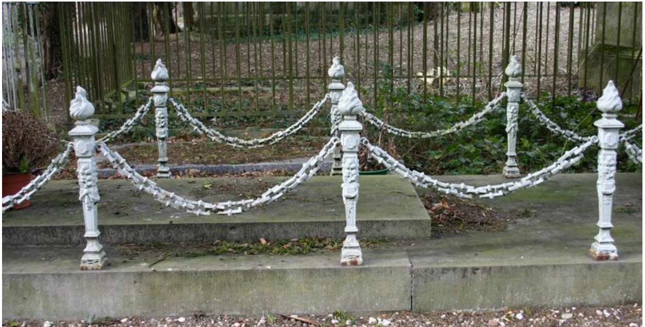
Clôture du tombeau, côté droit : piquets métalliques en forme de flambeaux.
