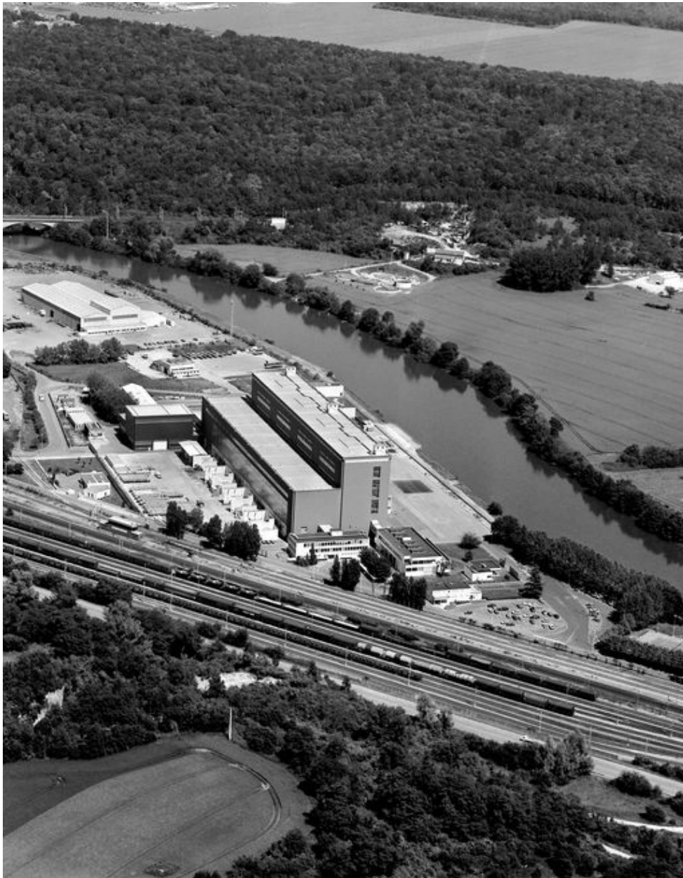
Vue aérienne de la centrale électrique vers le sud-est, en 1995 (Sanson Aviation).
