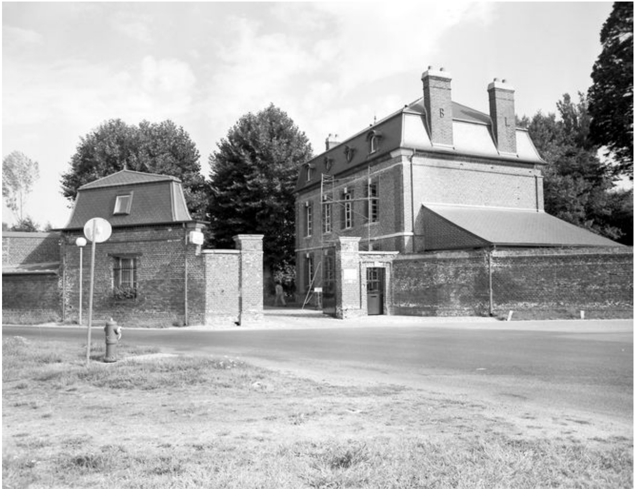
Le logement patronal et la conciergerie situés à l'entrée de l'usine, en 1999.
