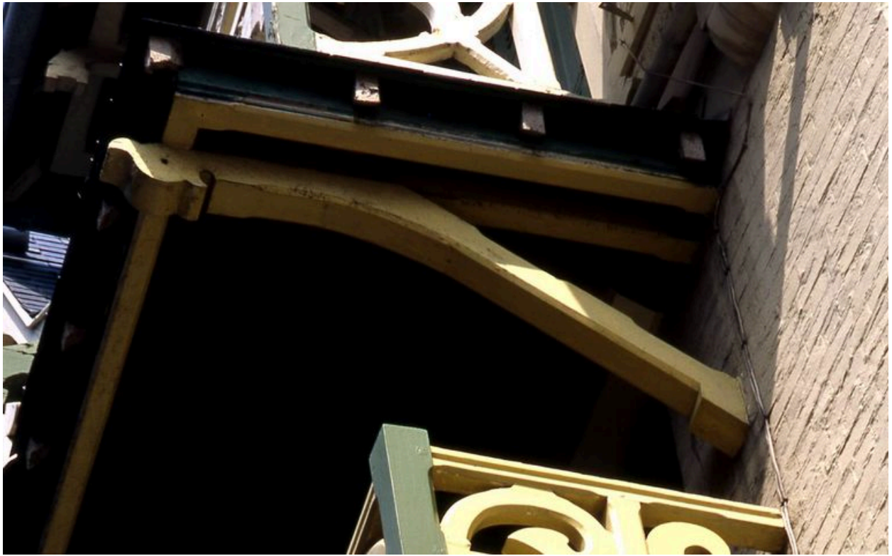
Détail d'un aisselier supportant la plate-forme du balcon du 2e étage-carré.
