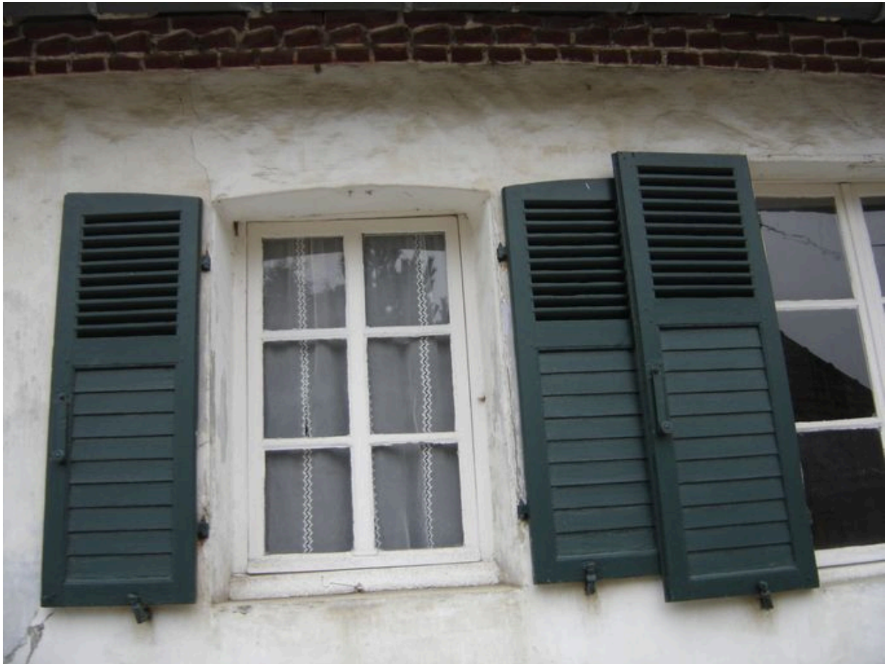
Détail de la fenêtre du logis qui semble dater du 18e siècle.
