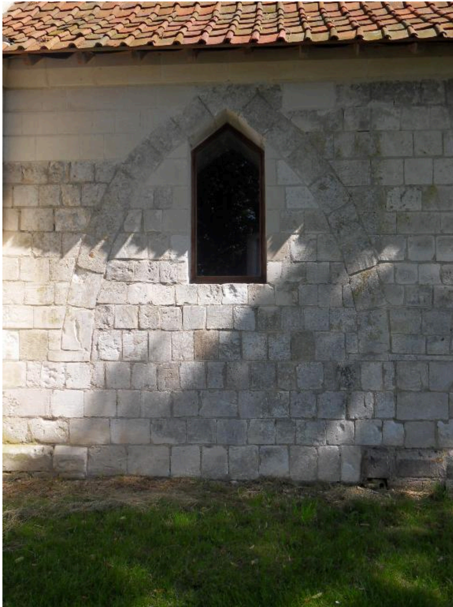
Première arcature mur sud.
