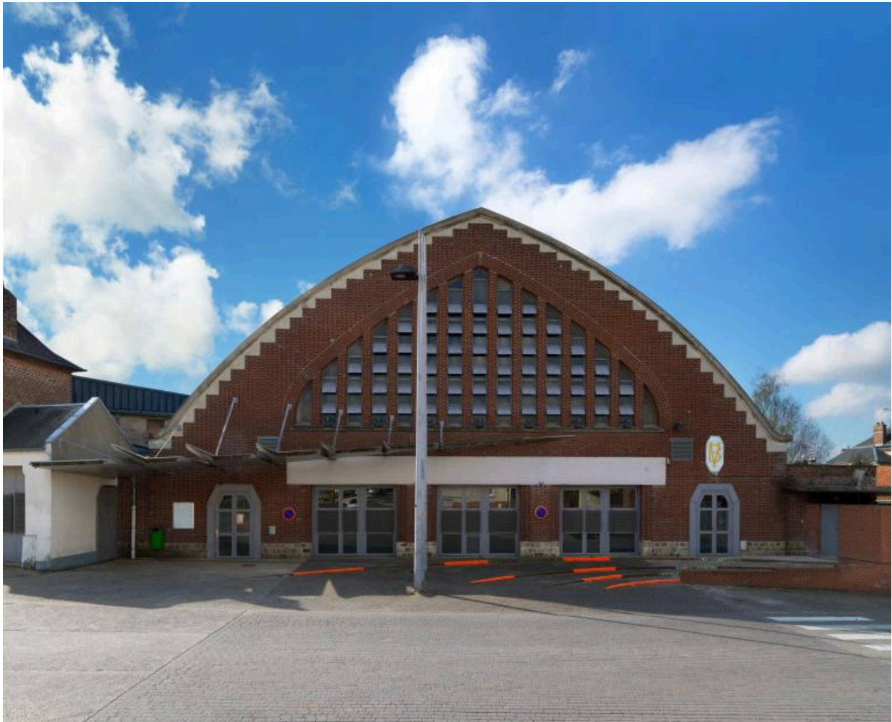
Vue de la façade nord.
