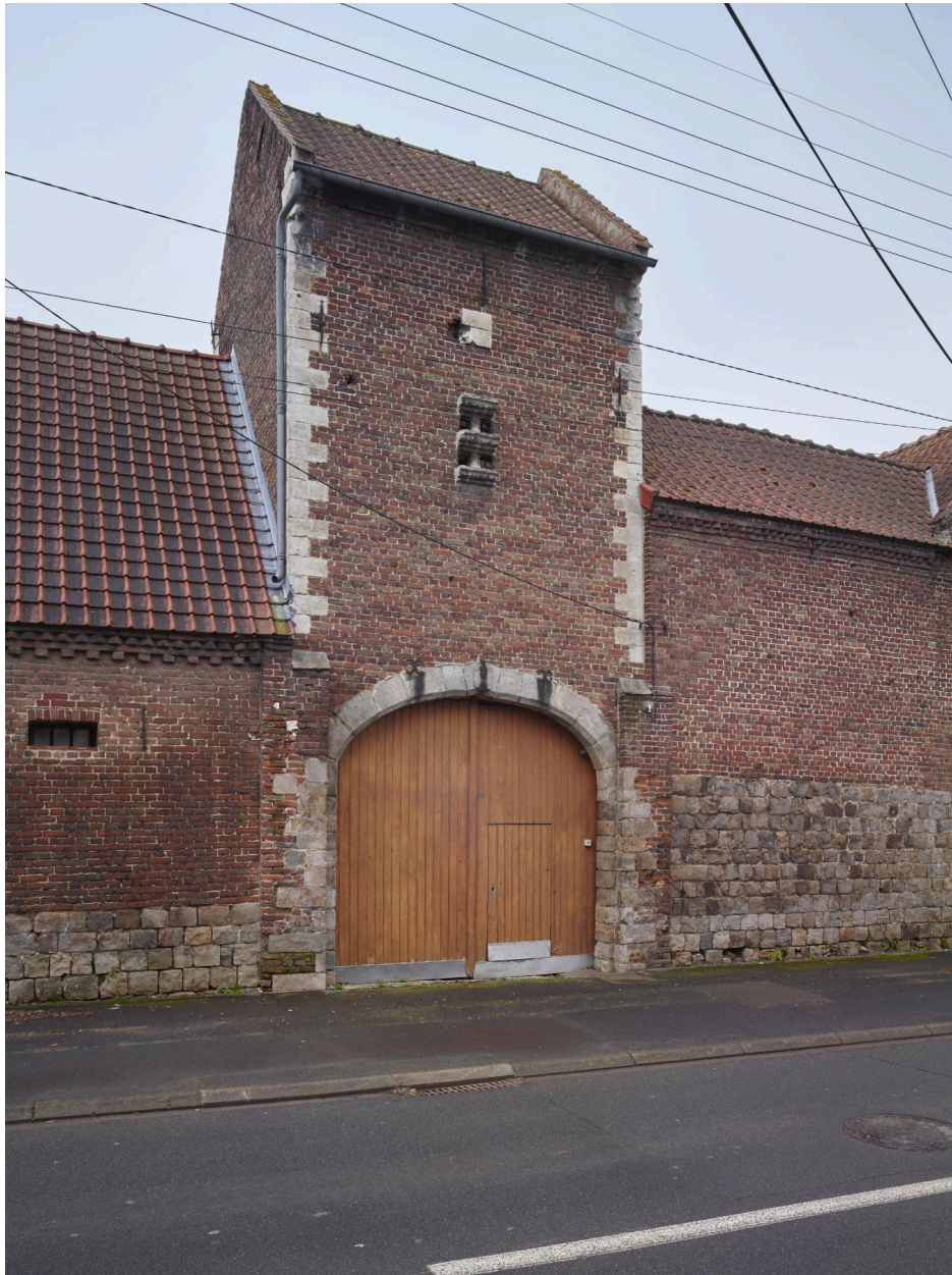
Tour porche. Entrée charretière de la ferme. Vue prise depuis la rue.
