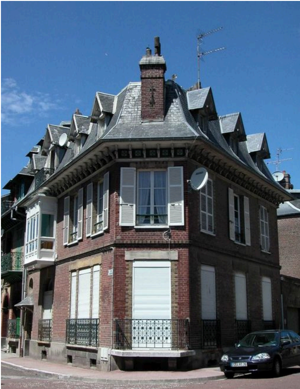
Vue d'ensemble depuis la rue Jules-Barni.
