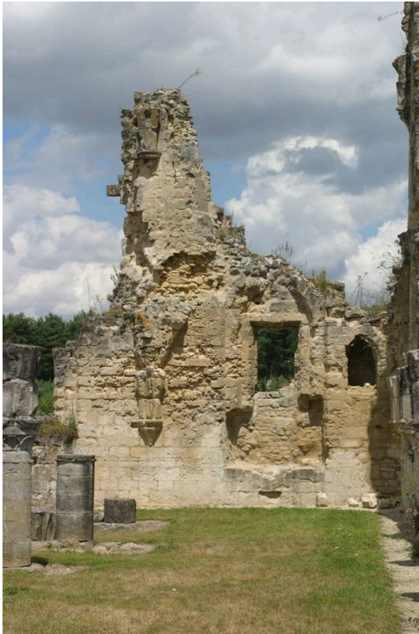
Vue partielle de la salle du chapitre.
