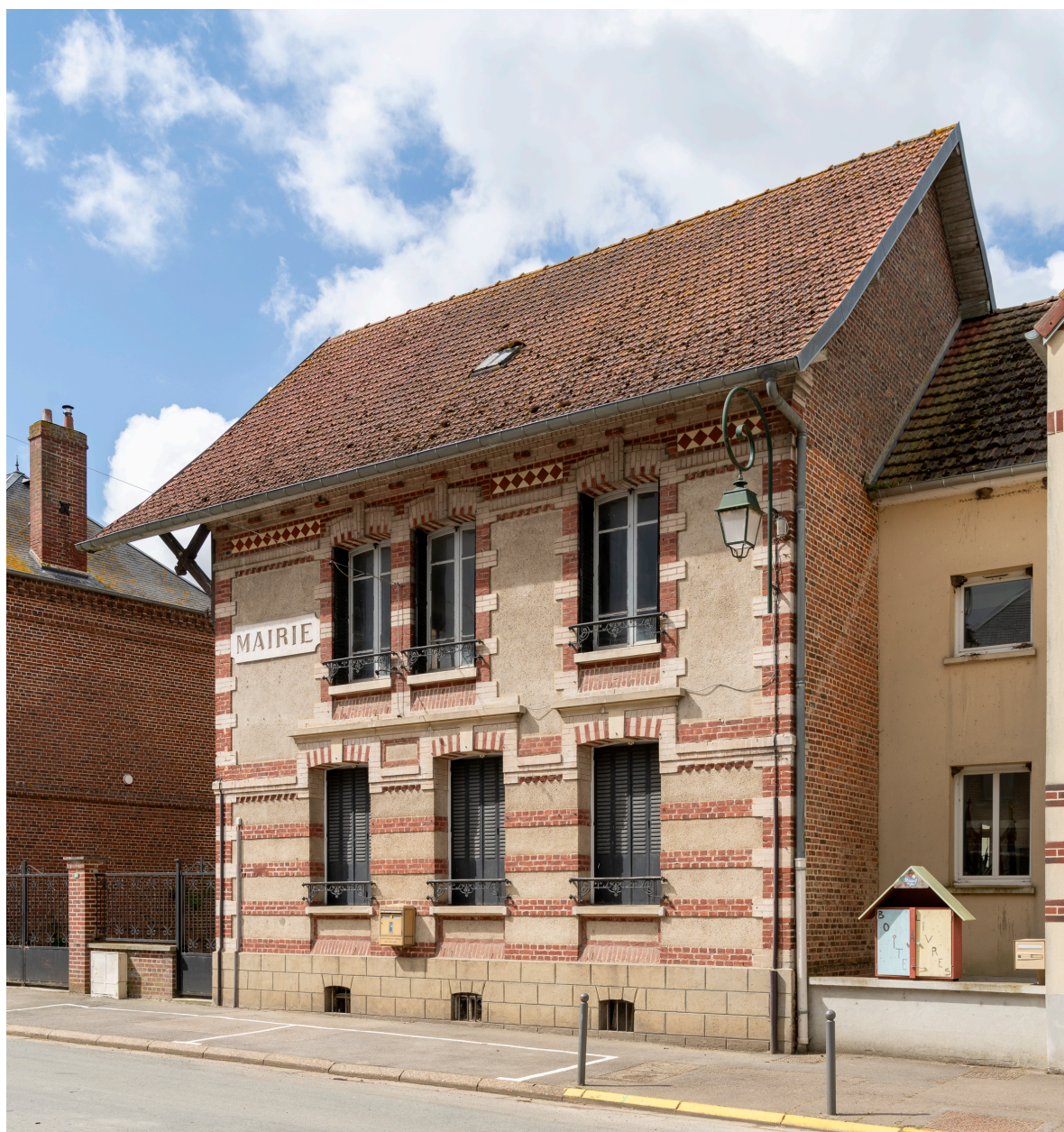
Mairie (ancienne villa "Les Pivoines"), n°2 rue de la Mairie, vue depuis le nord-est.
