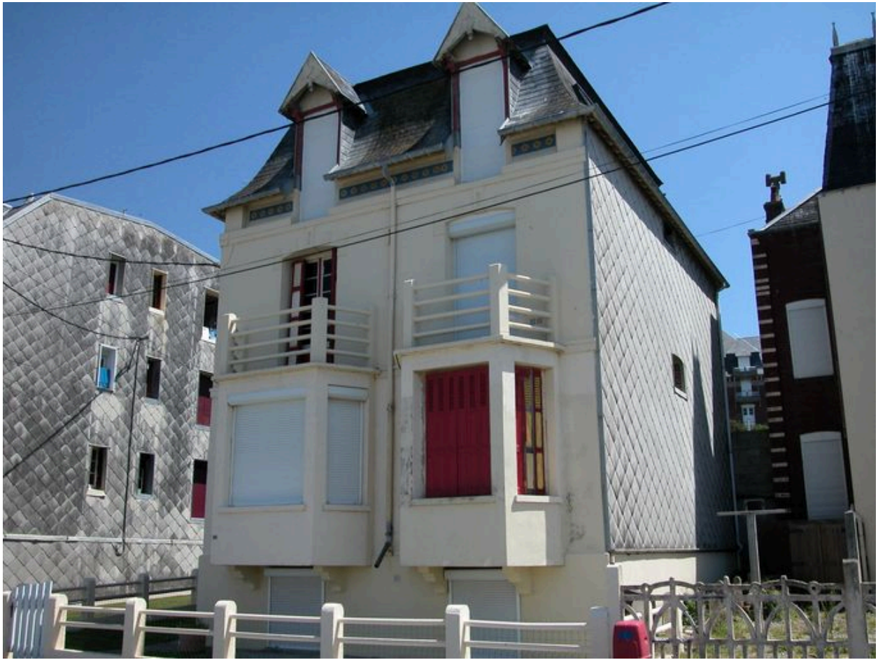
Vue d'ensemble, façade sur mer.
