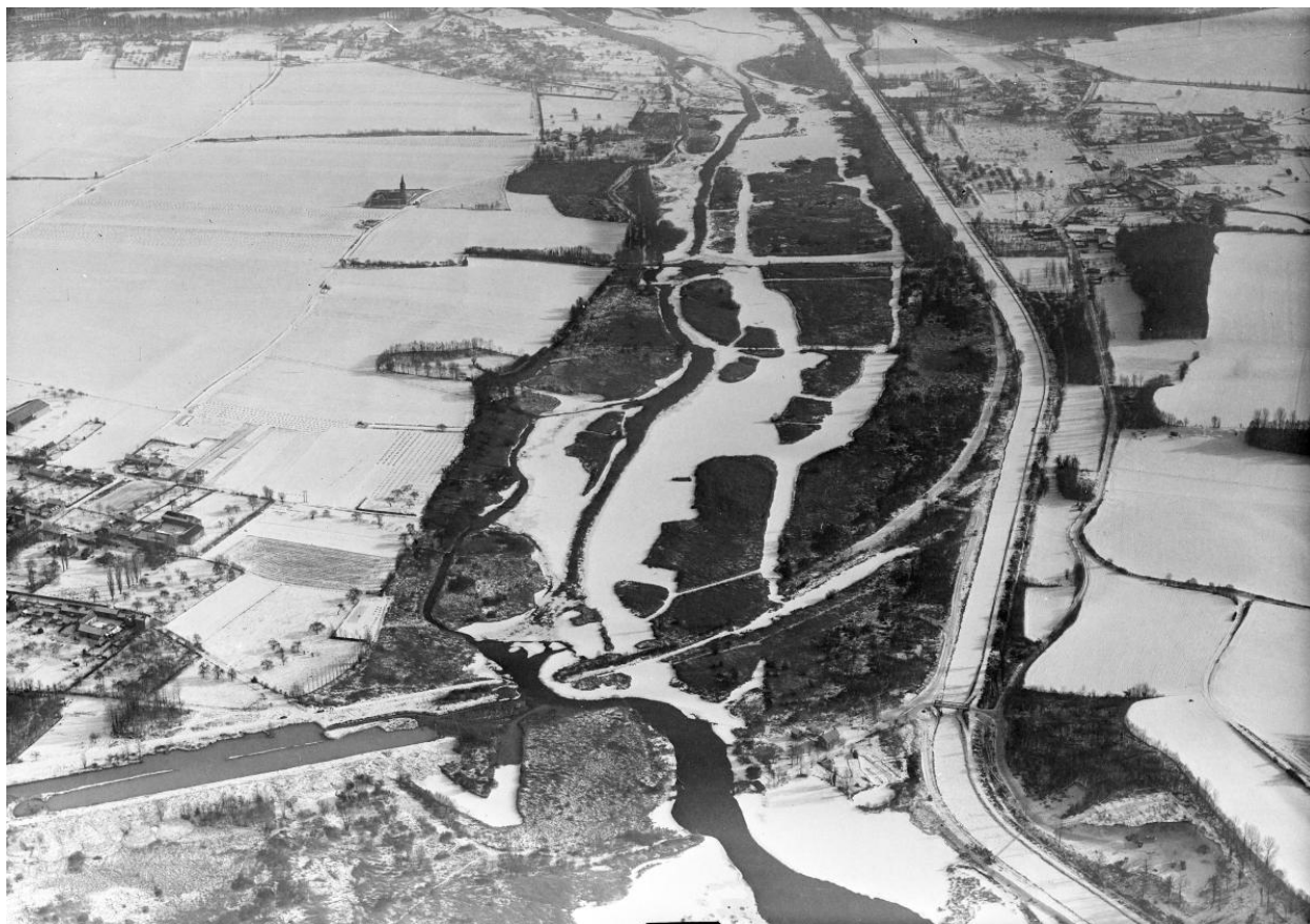
Vue aérienne de la jonction entre le canal de la Somme et le futur canal du Nord à hauteur de Biaches (Somme). (IGN. Photothèque Nationale. 1963).
