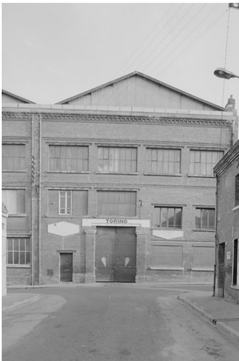
Atelier de fabrication, élévation antérieure.
