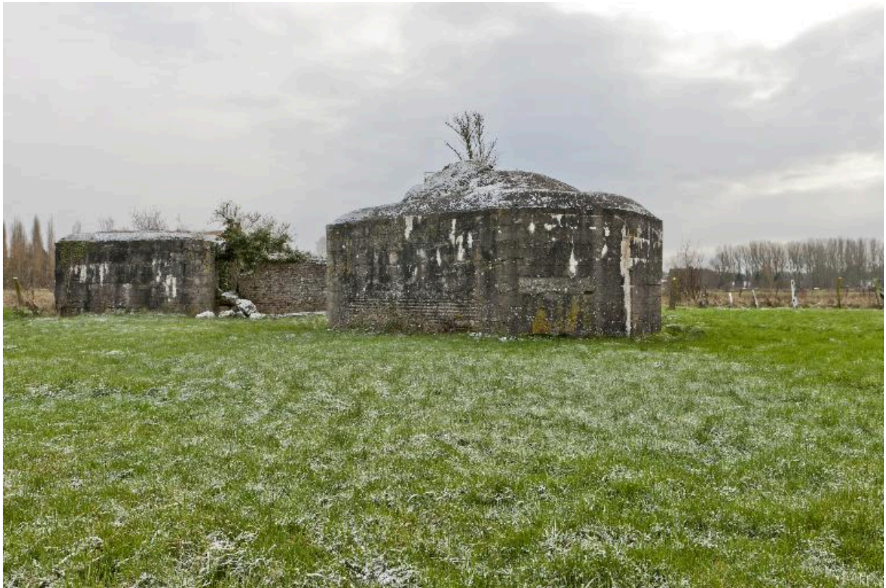
Vue générale, vers le sud
