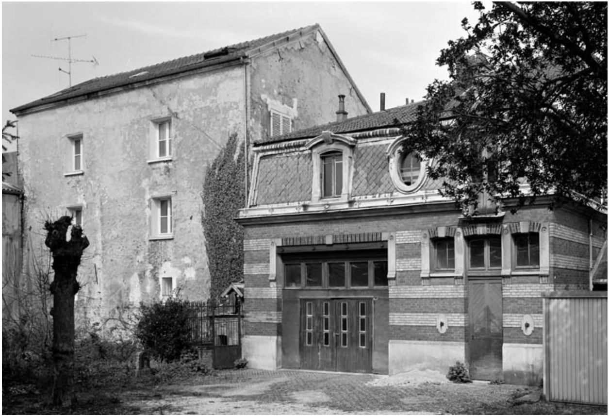
Les garages, anciennes écuries.
