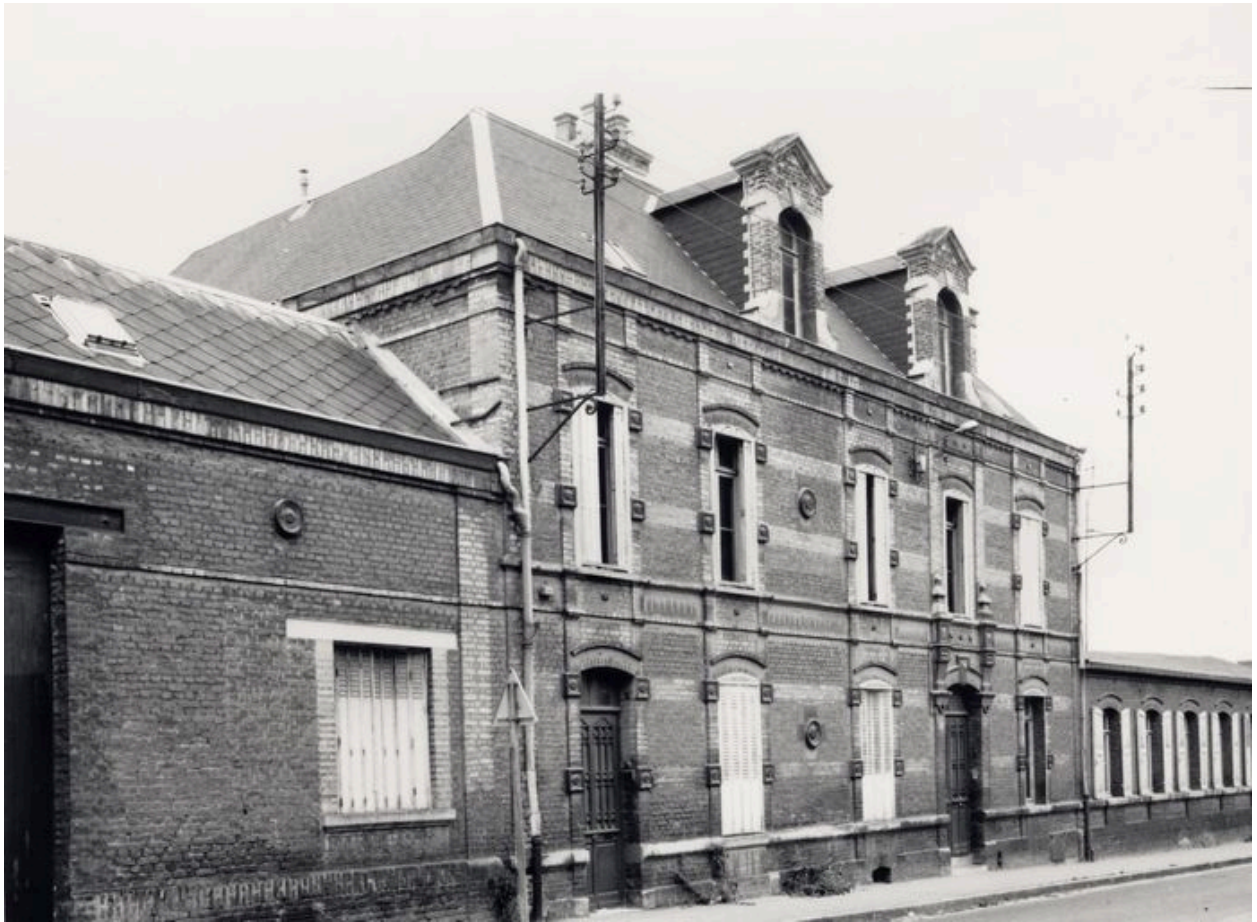
Le logement patronal, les bureaux et l'ancien magasin, vus depuis la rue au nord.
