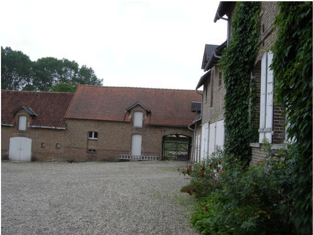
Vue de la cidrerie flanquée du corps de passage donnant accès à la pâture.
