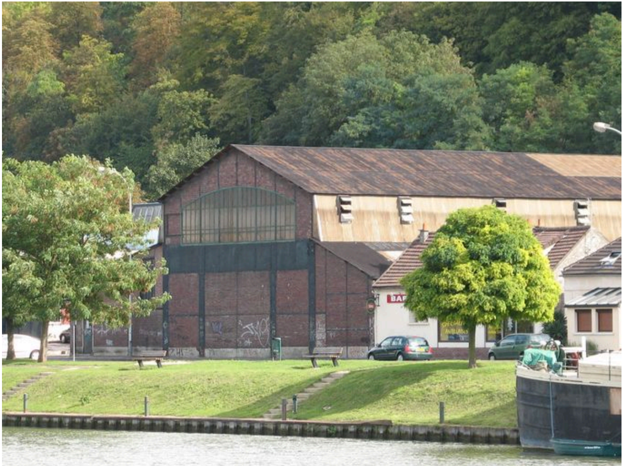
Vue générale de l'usine.
