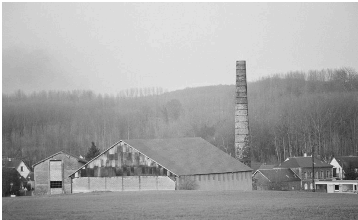
Bâtiments de l'usine et cheminée en brique.
