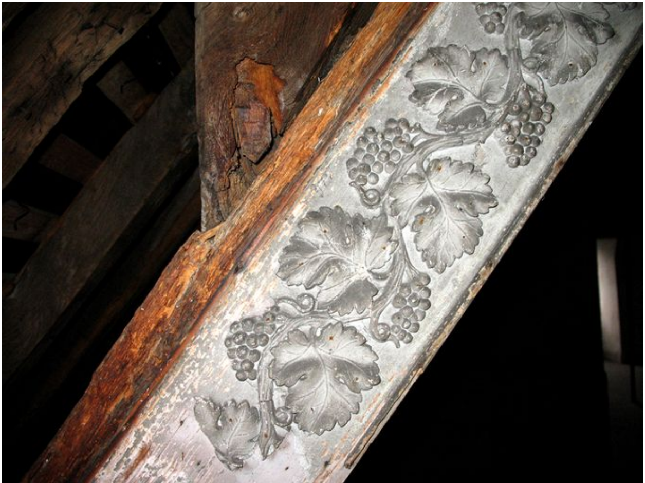
Linçoir de la charpente des combles sculpté de feuilles de vignes et de grappes de raisin.
