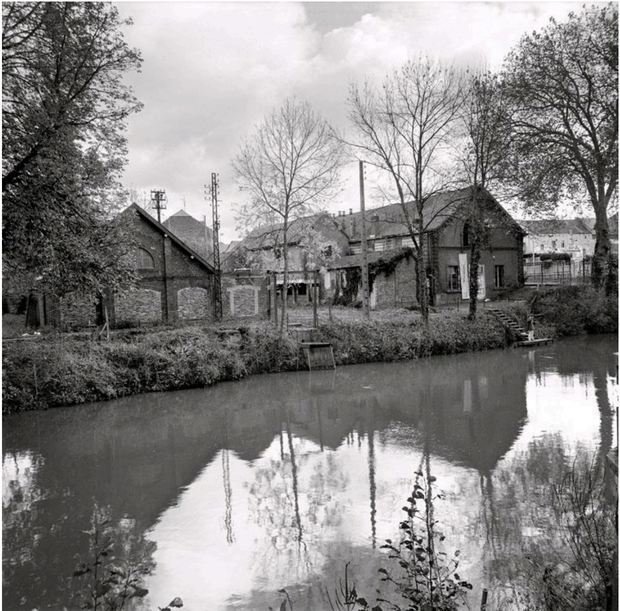
Vue générale, depuis l'Oise, des bâtiments.
