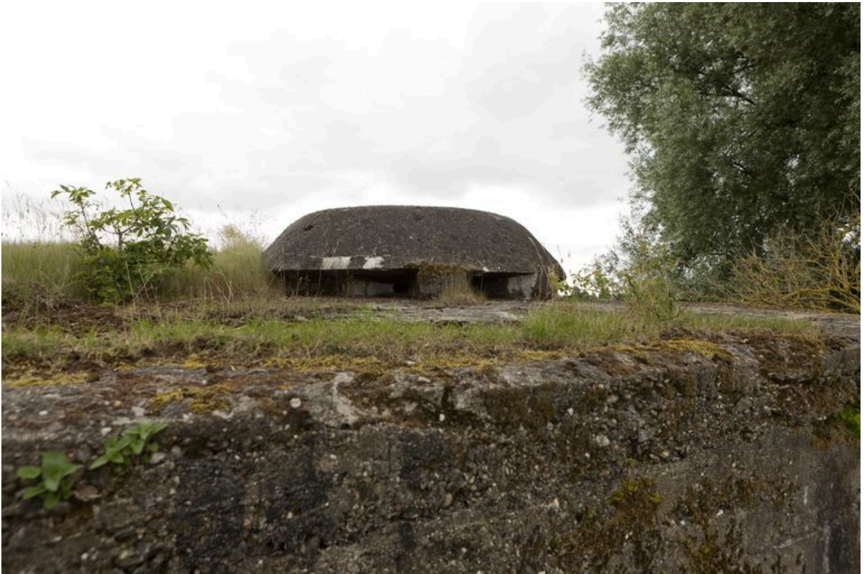
L'observatoire bétonné, vers le sud-ouest
